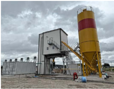
Weithin sichtbar sind die gro- ßen Silos unweit der Autobahn.
