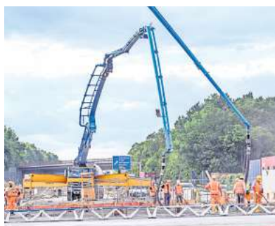
Wie Tentakel muten die Arme der riesigen Betonpumpen an.
